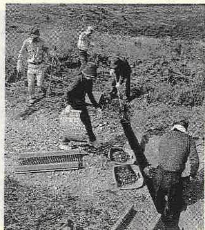
ボランティアによる道の修復
