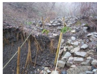
豪雨被害現場
